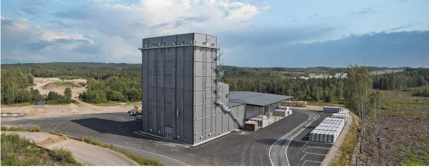
Рис. 9.2. Багатоповерхова промислова будівля
