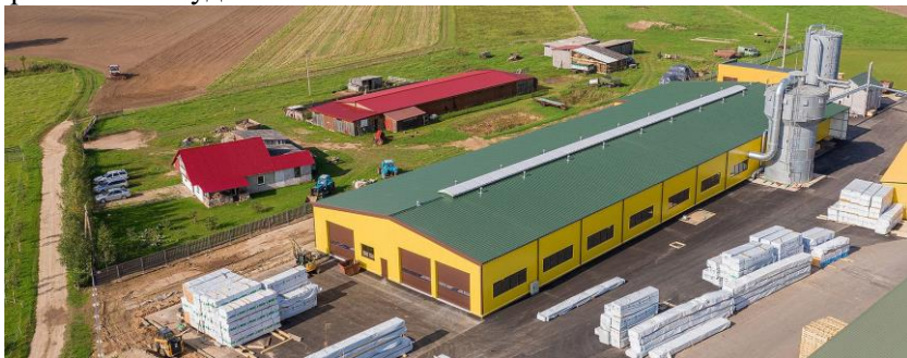
Рис. 9.1. Одноповерхова промислова будівля суцільної забудови
