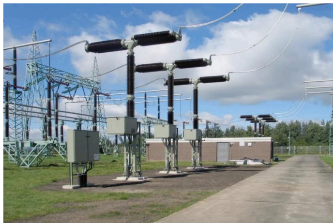
Рис. 3.8 Силовий вимикач [15]
