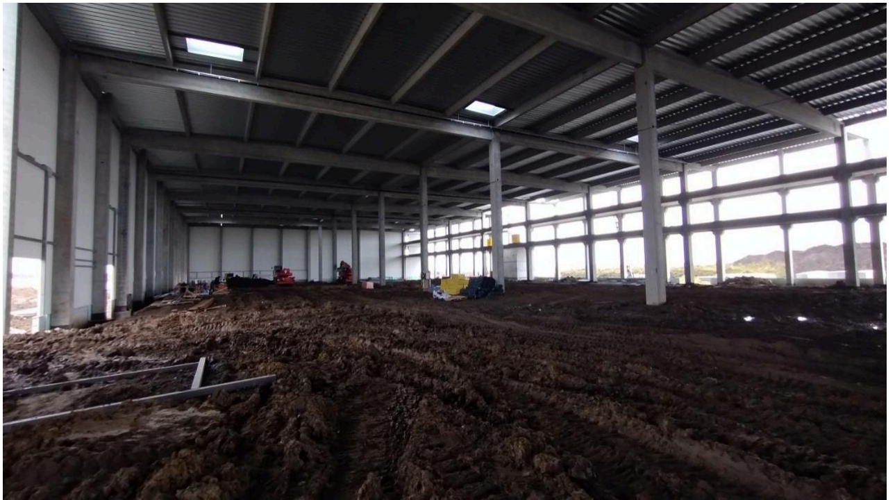
Рис. 2.1 Ділянка складського приміщення
