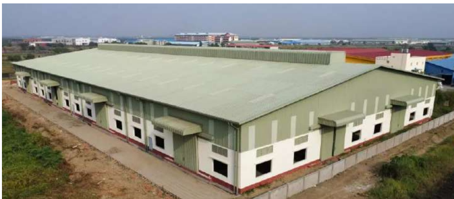
Рисунок 3.1 – Приклад одноповерхового модульного складу
